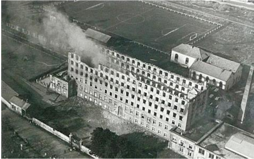
Usine Haussmann après l'incendie 1961 (Haussmann nach Brand 1961) / Photographie, documents remis
